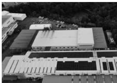
自動車に搭載される部品合成樹脂成形品の成形・塗装・組付けをしている柿野にある工場
